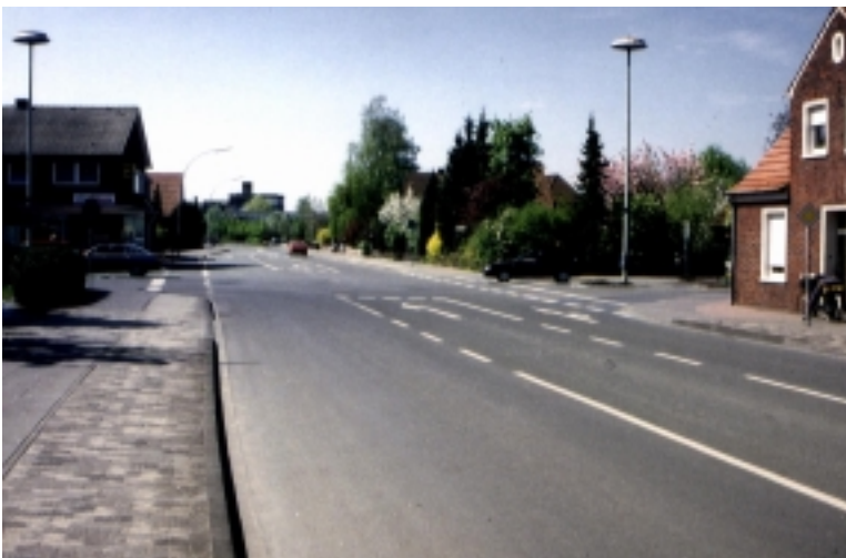
Bild 25: Gescher - Kreuzung im Vorher-Zustand
