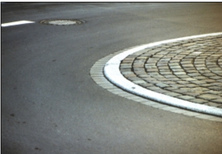
Bild 8: Bord zur Einfassung der Kreisinsel
