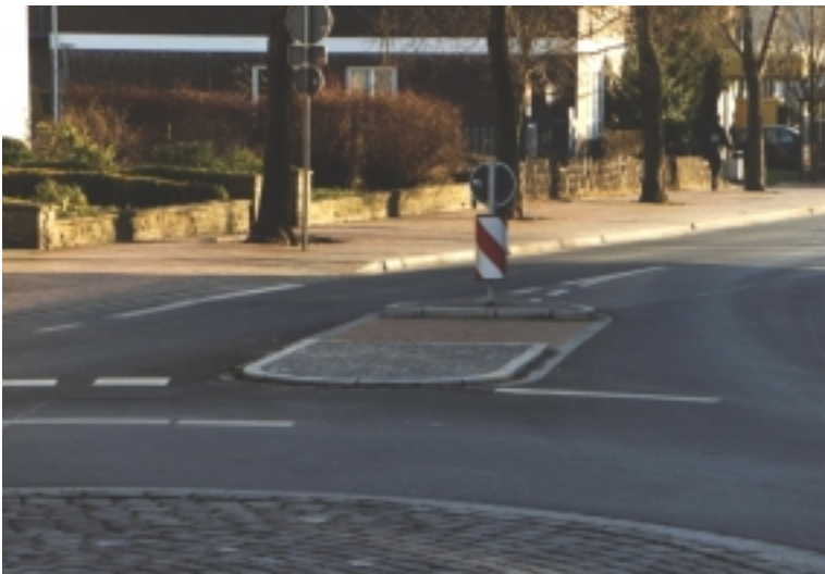
Bild 10: Teilweise überfahrbarer Fahrbahnteiler
