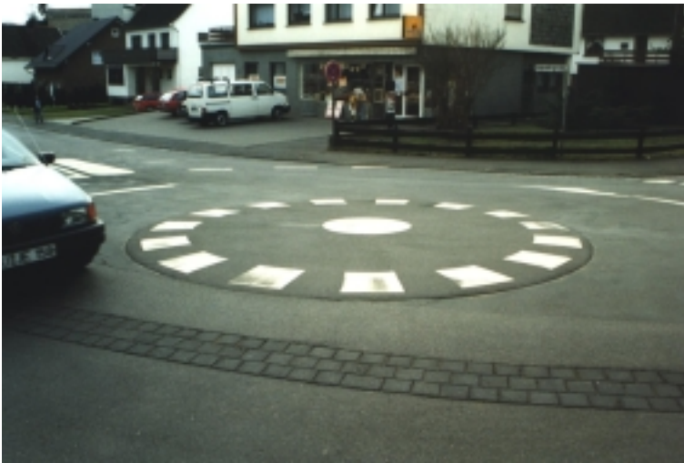
Bild 5: Asphaltierte Kreisinsel
