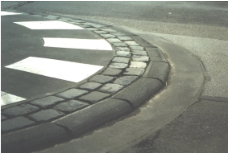
Bild 9: Bord zur Einfassung der Kreisinsel
