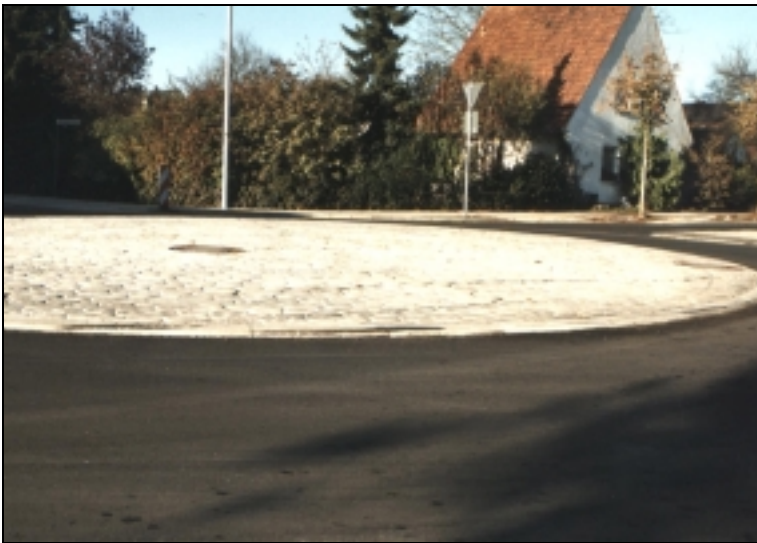
Bild 7: Betonierte Kreisinsel
