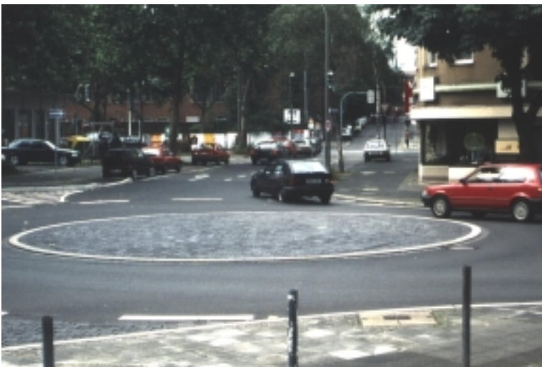
Bild 6: Gepflasterte Kreisinsel
